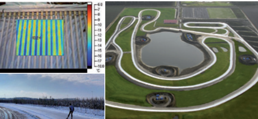
Links boven: Thermografiefoto.
