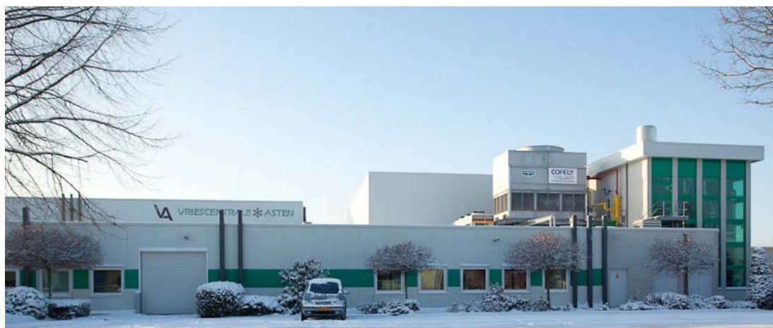
Foto 1. Zijaanzicht Vriescentrale Asten met rechts voor NH_3/CO_2 machinekamer en daarachter de dozenvriezer.
