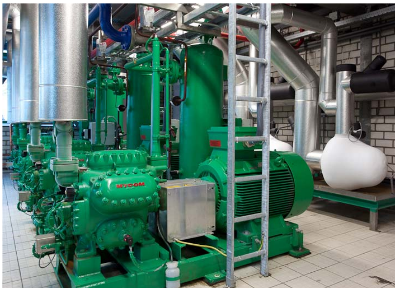
Foto 5. CO 2 zuigercompressoren
